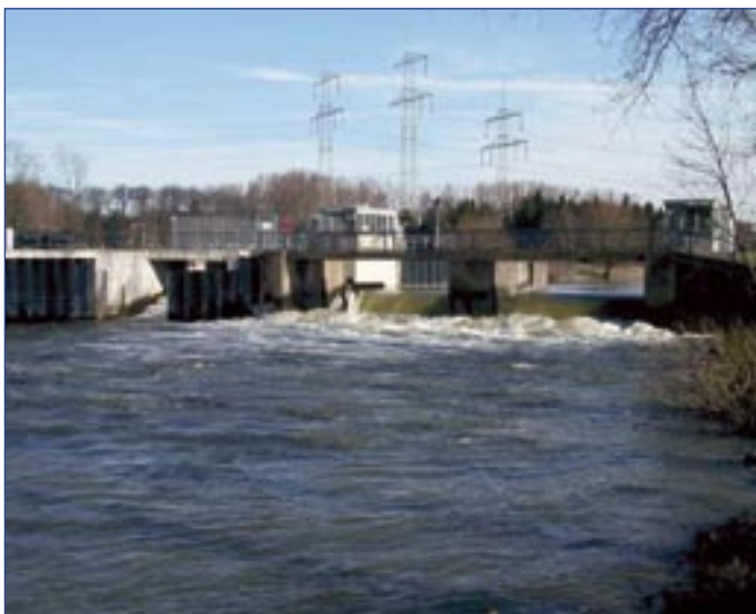
Wasserkraftwerk Hamm-Uentrop. Wie an der Lippe erzeugt RWE entlang der Ruhr, der Mosel, der Nahe und Rur in vielen Wasserkraftwerken seit Jahrzehnten Strom
