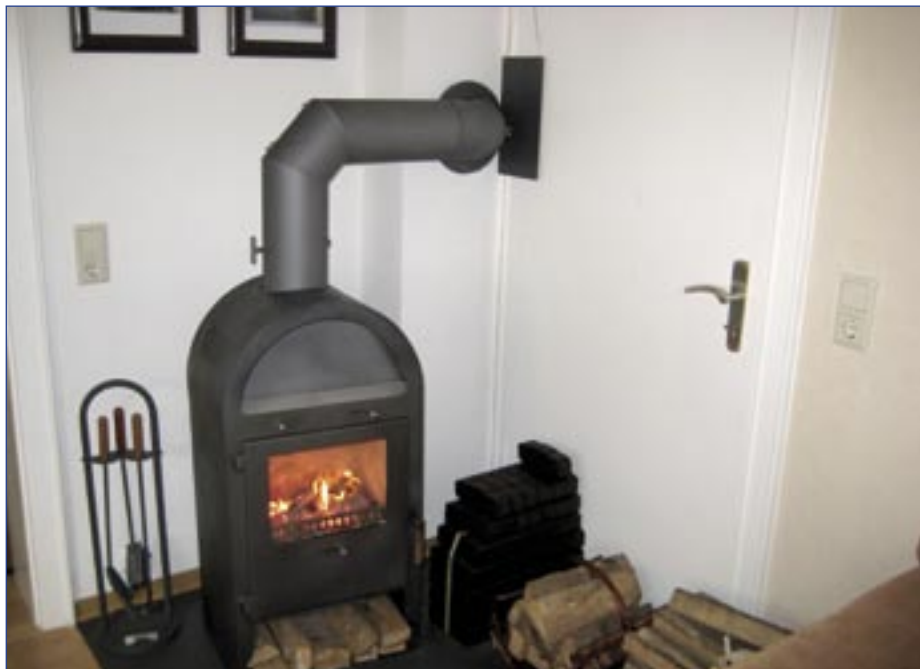
Richtig: ein ausreichend bemessenes Blech schützt den Fußboden vor Funkenflug und Brandflecken Falsch: das Ofenrohr ist zu nah an der Zimmertür – Verformungs- und Brandgefahr die Bilder über dem Abgasrohr haben es auch nicht gerne zu warm Wohin mit dem Brennholz? Dekorativ ist dies so gewiss nicht.
