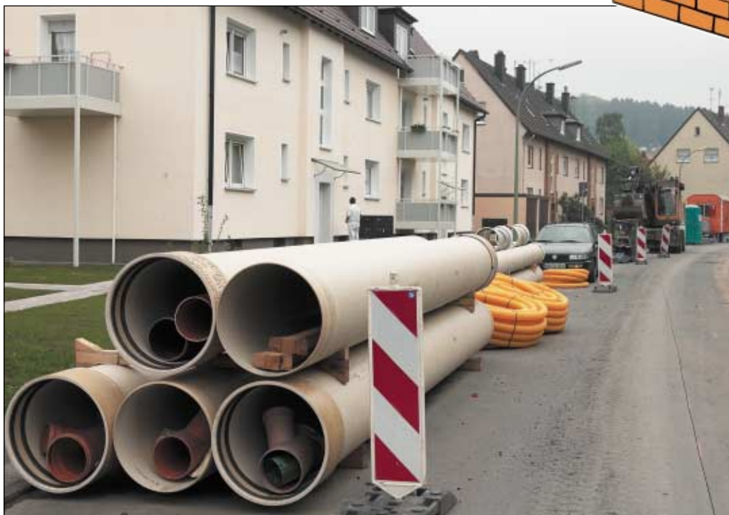
Neue Kanäle werden im Gladenbruch verlegt.
