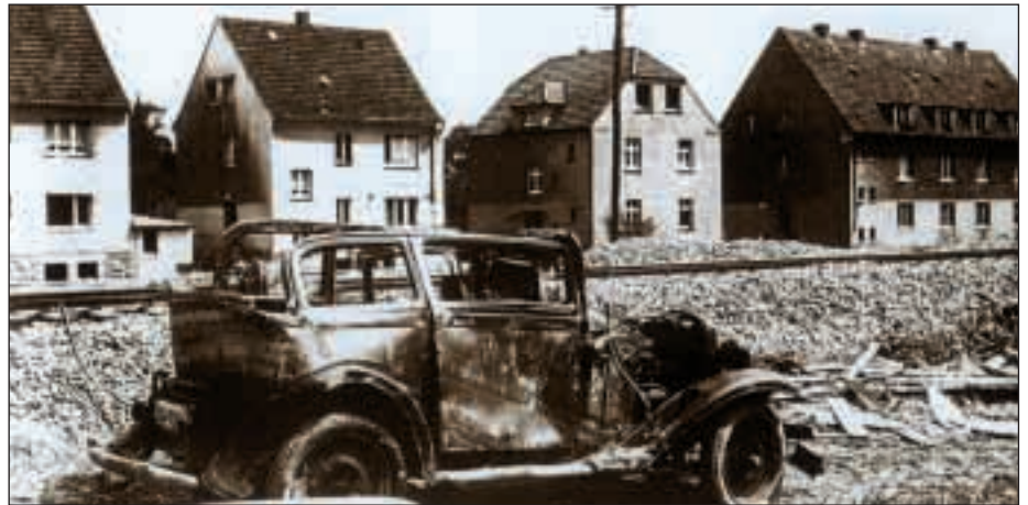
Die Steinstraße wurde überschwemmt.
